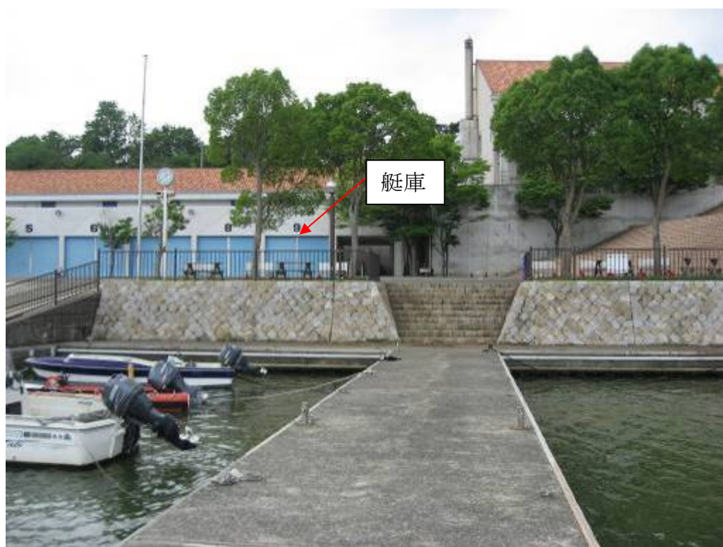
写真16 ハーバー（艇庫）の状況
