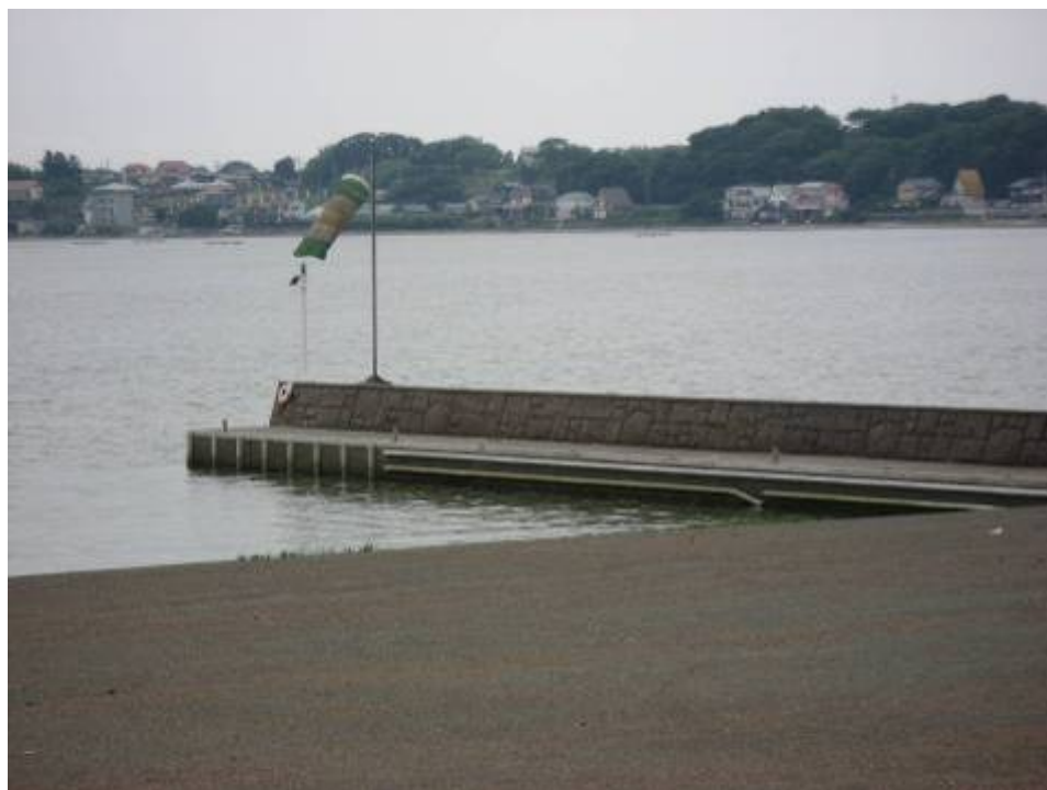
写真 2 1 吹き流しの状況
