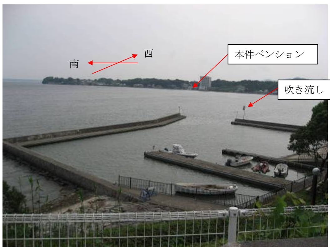
写真15 ハーバー付近の状況
